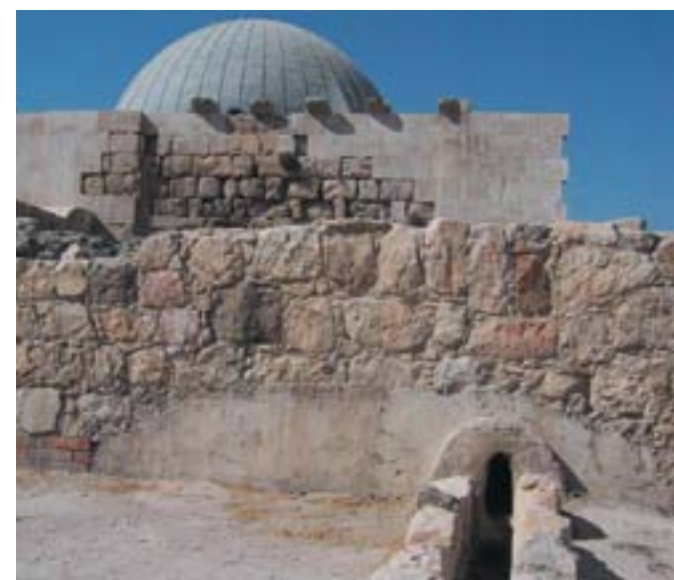
(الشكل ٢١): نظام تجميع مياه الأمطار في جبل القلعة والذي يشمل قنوات لتوصيل المياه من سطوح المباني إلى خزان كبير لمياه الأمطار.
